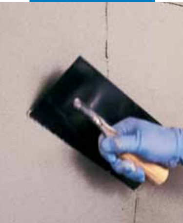
Applicazione di Planitop 560 con spatola metallica
