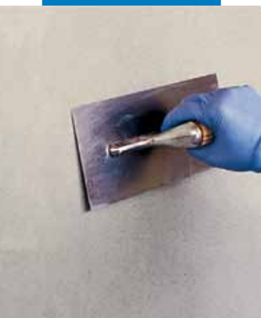
Lisciatura della superficie di Planitop 560 con spatola metallica
